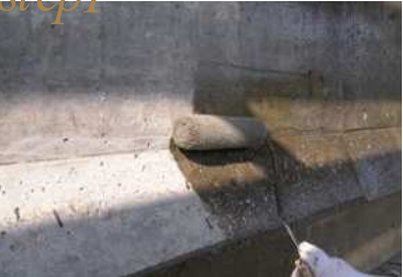
プライマー塗布
